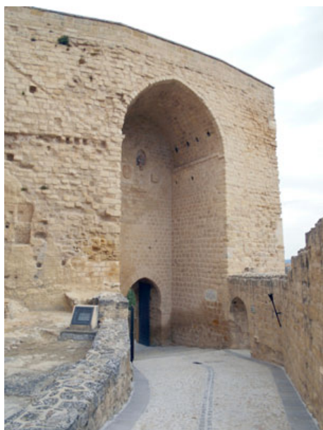
Fig. 23: Vista oeste de la puerta de la Imagen. Fotografía: Heol Escudié-Lacroix (12/09/2015).
