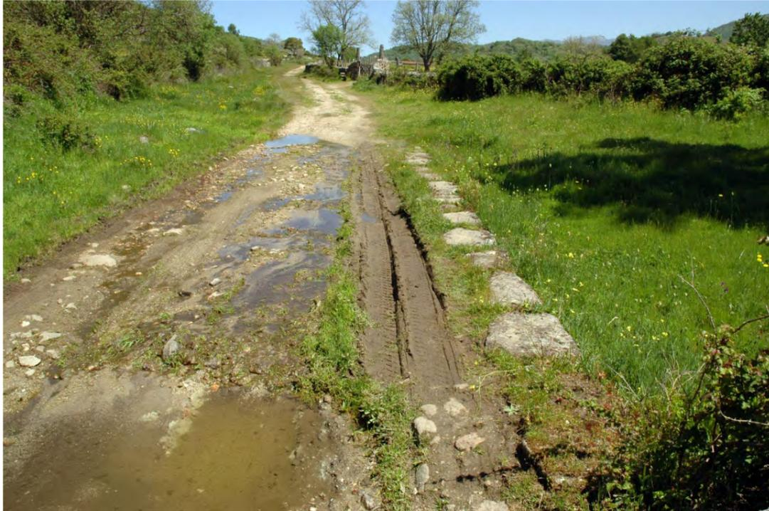
Losas laterales del Camino Real en la margen derecha del río Cuerpo de Hombre. Estos bordillos de gran tamaño, destinados a ser vistos, son los propios de la estructura del Camino Real, tal y como se ven en la subida a Puerto de Béjar.
